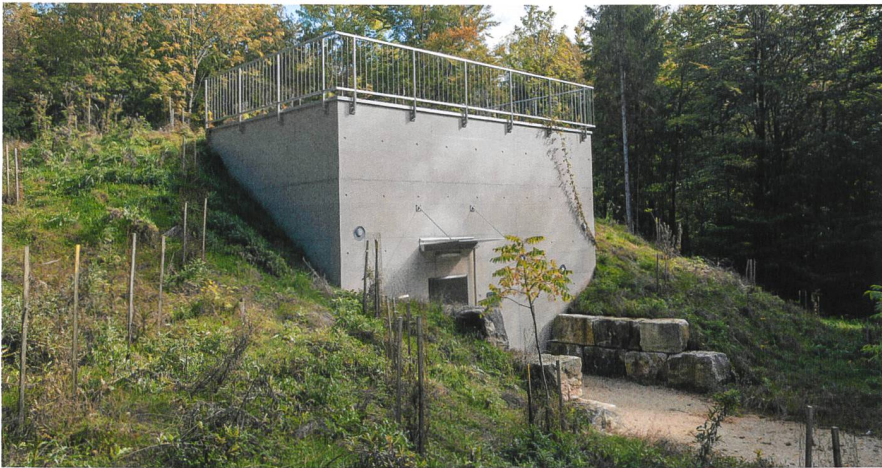
Das im Jahr 2018 eröffnete Reservoir Rindel fasst 280 m 3 .
