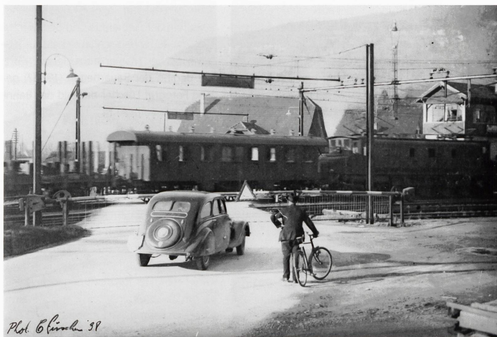
Der Übergang südlich des Bahnhofes mit Barriere blieb trotz zügiger Planungsarbeiten und fortschreitender Dorfbachkorrektur bis in die späten Dreissigerjahre bestehen.
