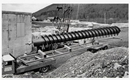
Einbau der mächtigen Förderschnecken im Abwasserhebewerk.
