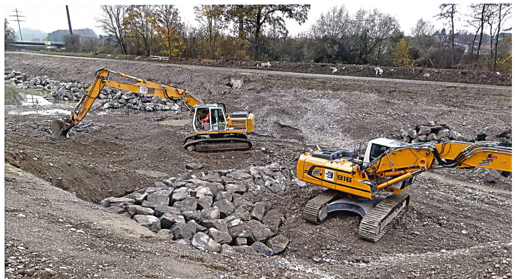
Bau einer Bühne aus Steinblöcken (November 2014)
