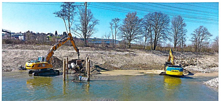
Bau einer Holzbühne (Mai 2015)
