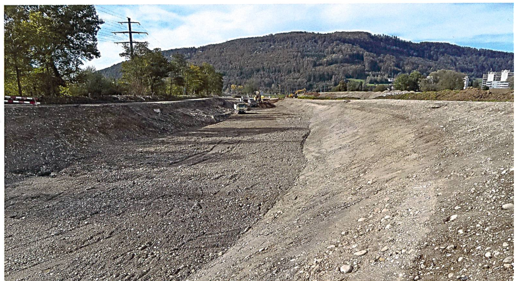
Ausheben des neuen Flussbettes (Oktober 2014)
