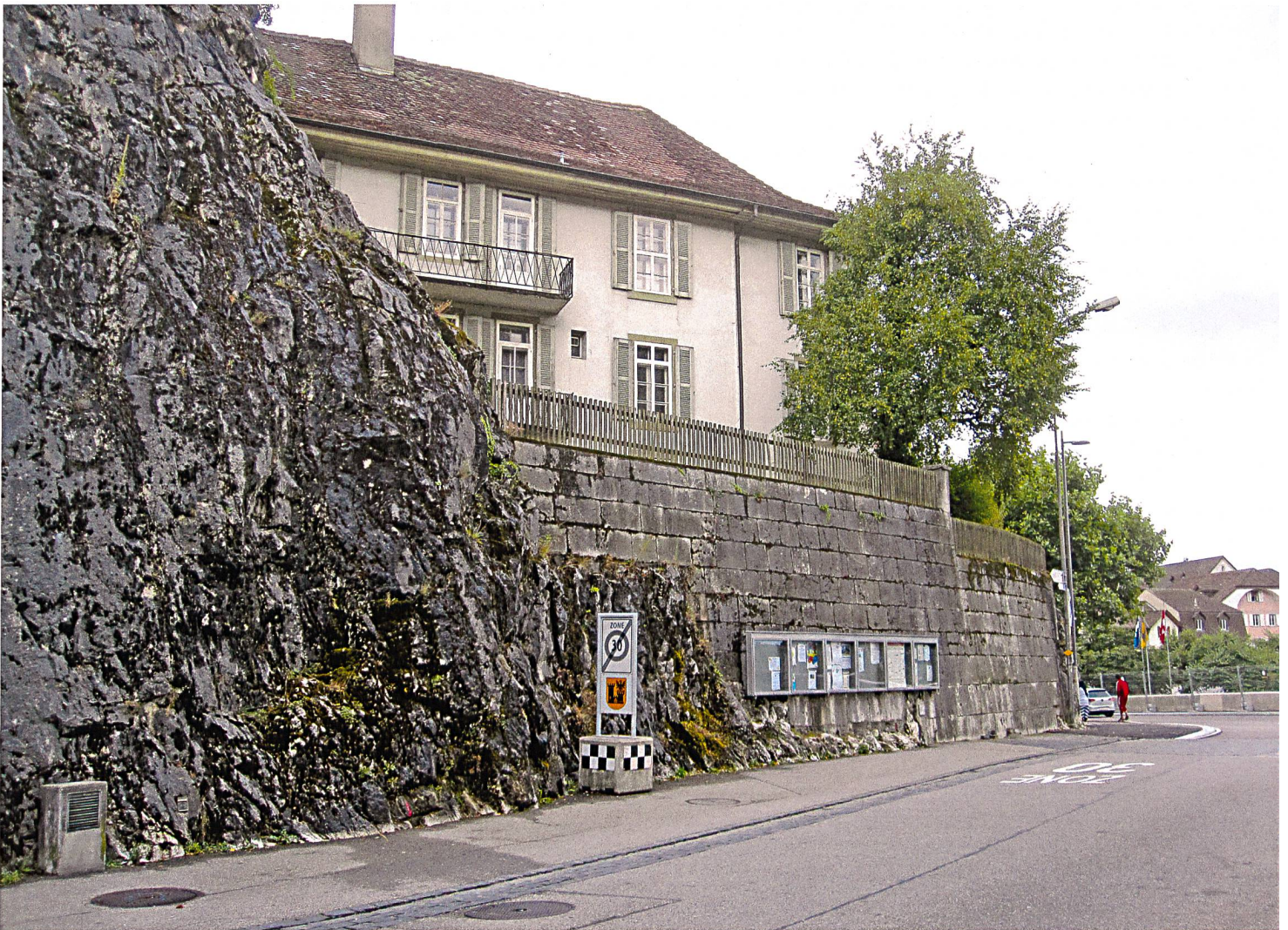
Hier schliesst die Quadersteinmauer an den Festungsfelsen an. Bei der Sprengung dieser Felspartie wurde der ominöse Sandkasten demoliert. Am Fuss der Mauer hängt bis heute der Anschlagkasten der Gemeinde. Foto: Peter Schärer, Juli 2015
