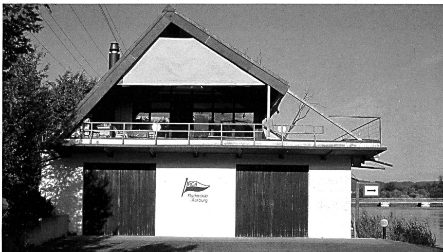
RCA-Bootshaus heute – erweist sich als ein gelungenes Beispiel für einen dem Rudersport dienenden Zweckbau aus dem Jahr 1968. Architekt: Max Morf, Aarburg. (Foto: Peter Schärer)
