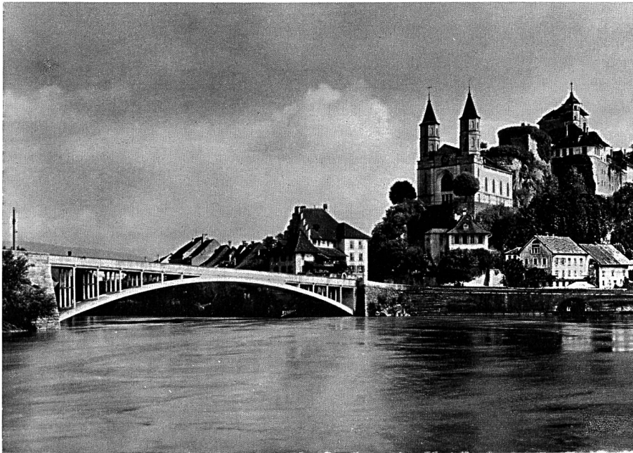
Die fertiggestellte Brücke im Jahr 1912.
