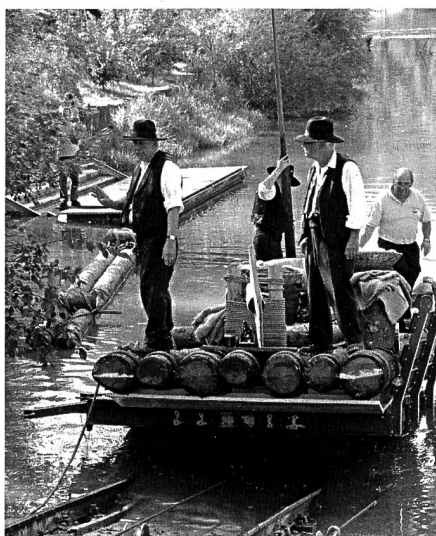
Mit Motorkraft über das Wehr.
