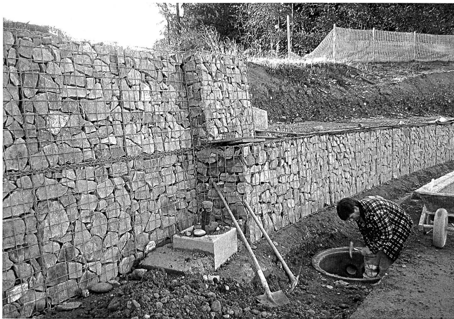
Steinkörbe zum Erstellen von Steilböschungen.
