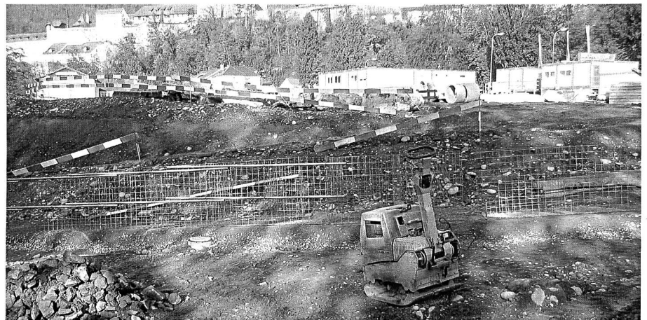
Vorarbeiten für die Steilböschung.
