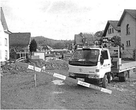
Stand der Arbeiten im Bereich der Alten Zofingerstrasse.
