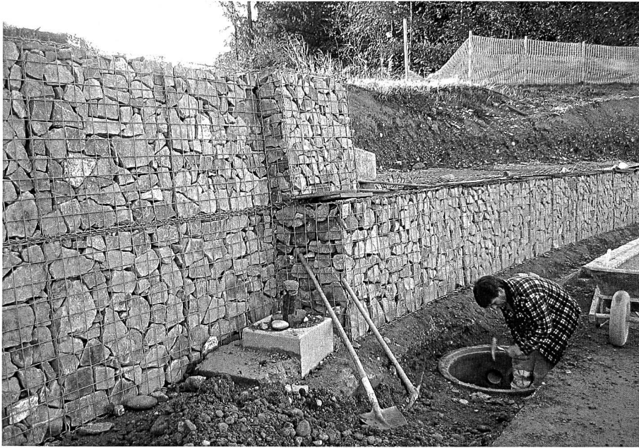
Steinkörbe zum Erstellen von Steilböschungen.
