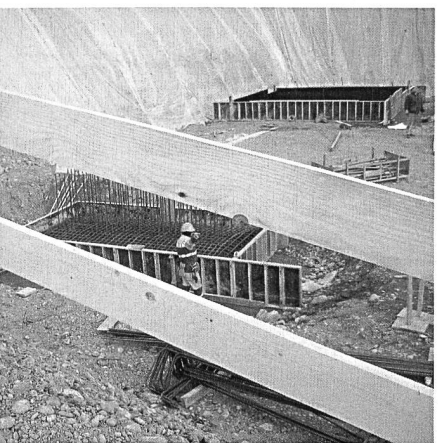
Stützen zur Überführungsrampe Richtung Oftringen.
