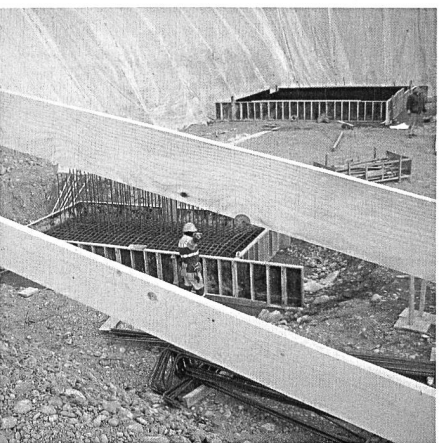
Stützen zur Überführungsrampe Richtung Oftringen.
