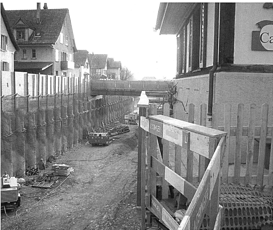
Der überhängende Zugang zum Garten.
