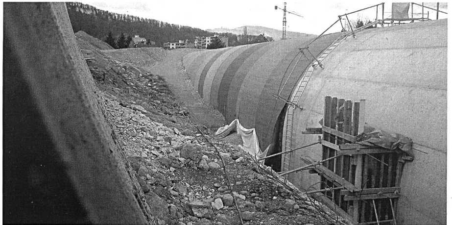
Im Tagbau erstellte Tunnelröhre.
