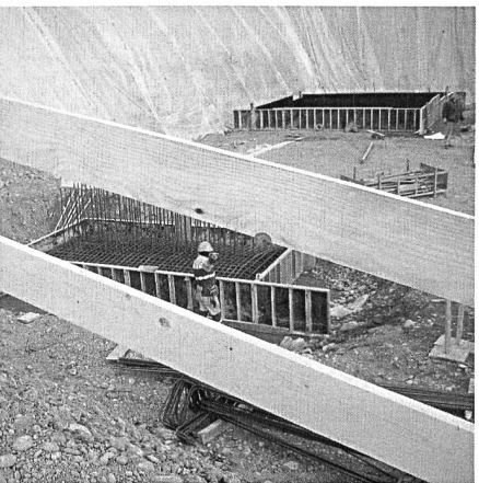
Stützen zur Überführungsrampe Richtung Oftringen.
