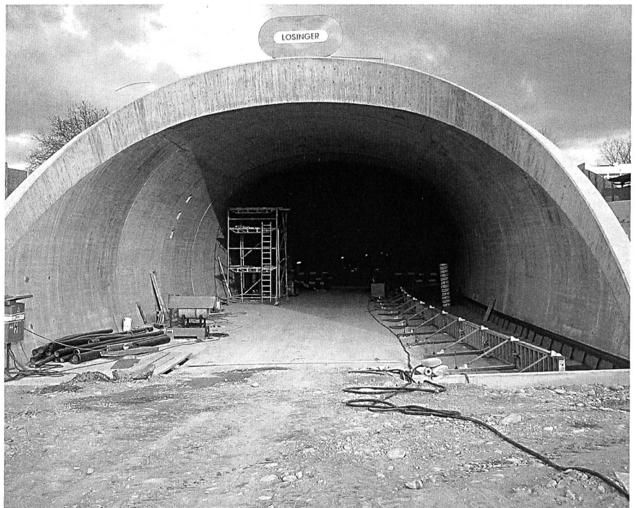
Das architektonisch gestaltete Tunnelportal Paradiesli.
