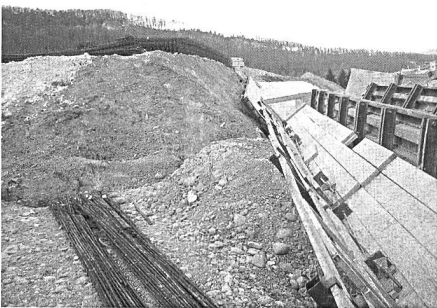
Sortengetrennte Aushubberge auf der Nordseite.
