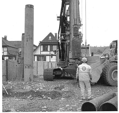
Pfahlbohrmaschine zur Aufnahme der Stützen zur Böschungssicherung.
