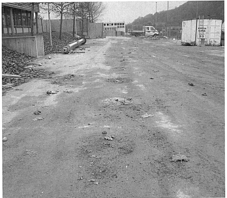
Die Rühlwandpfähle zur Böschungssicherung neben der Mehrzweckanlage sind schon gesetzt und eingedeckt.
