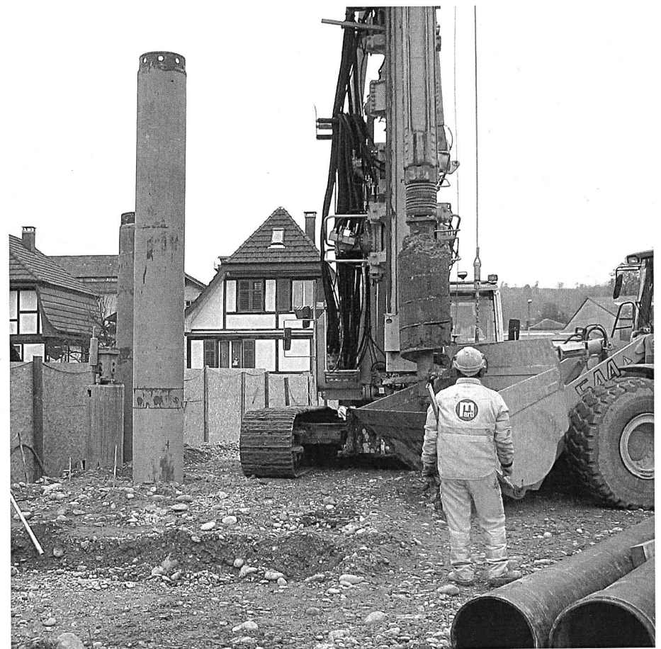
Pfahlbohrmaschine zur Aufnahme der Stützen zur Böschungssicherung.
