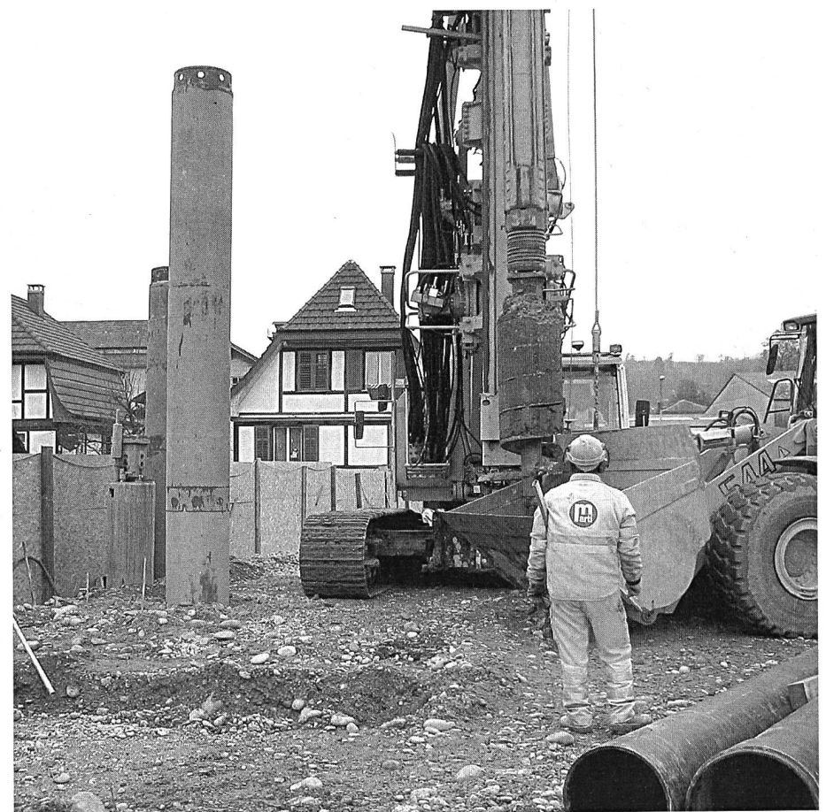
Pfahlbohrmaschine zur Aufnahme der Stützen zur Böschungssicherung.
