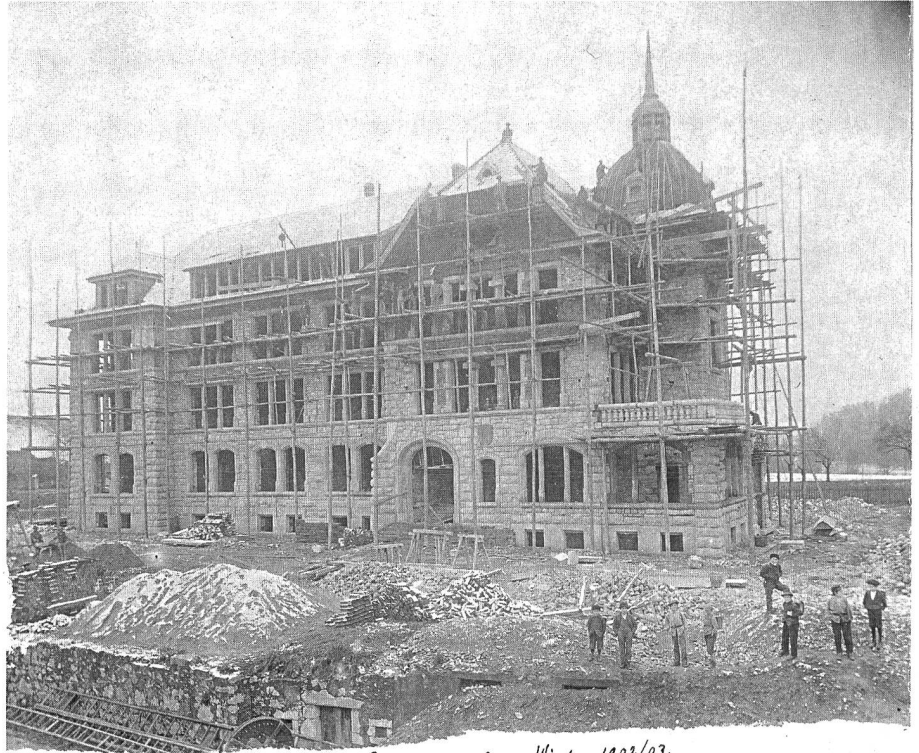
Gemeinderschulhaus Winter 1902/03. im Vordergrund die zugeschüttete Parterrewohnung des alten Herrenspittels.
