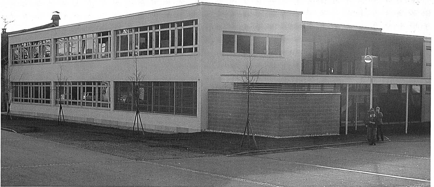
Der neue Anbau.
