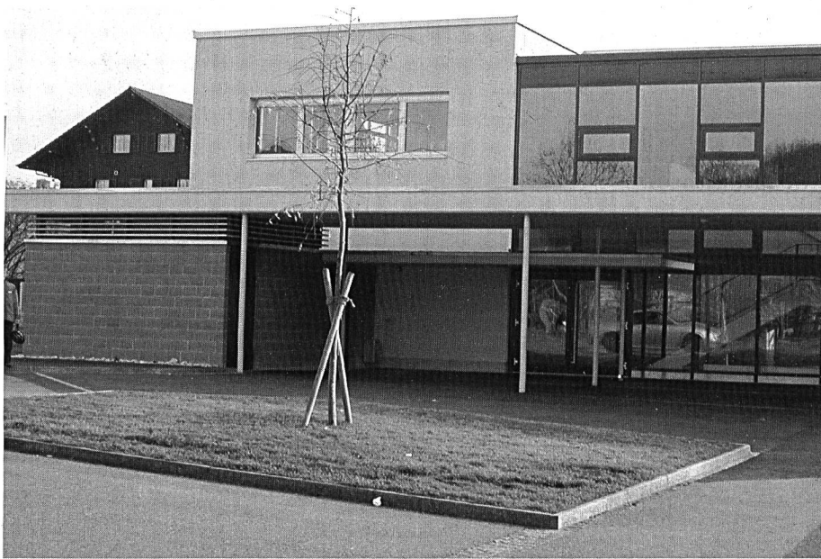
Die Integration zwischen Alt- und Neubau ist vorbildlich gelungen.
