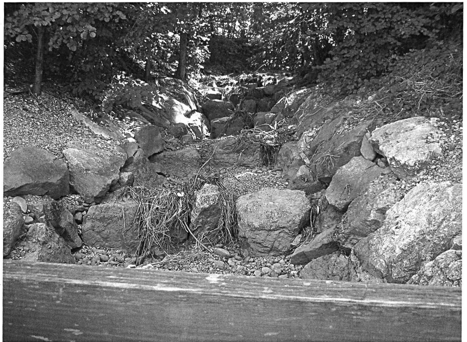
Am 3. September 2003 präsentierte sich der Auslauf des Rotkanals wie auf dem Bild. Das Gewässer war völlig ausgetrocknet, obwohl der Fischenz-Oberlieger aus Roggwil für seine Pachtstrecke eine Restwasserdotierung von 200 l/sec bestätigte.
