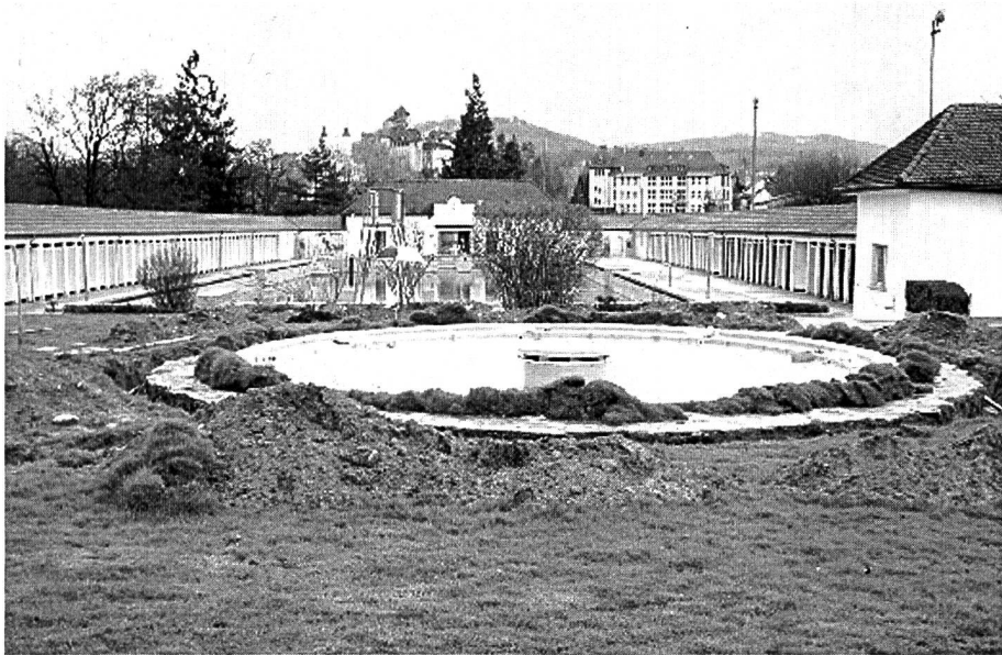
Auswechslung der Ringleitung um das Kinderbassin im Frühjahr 2001.
