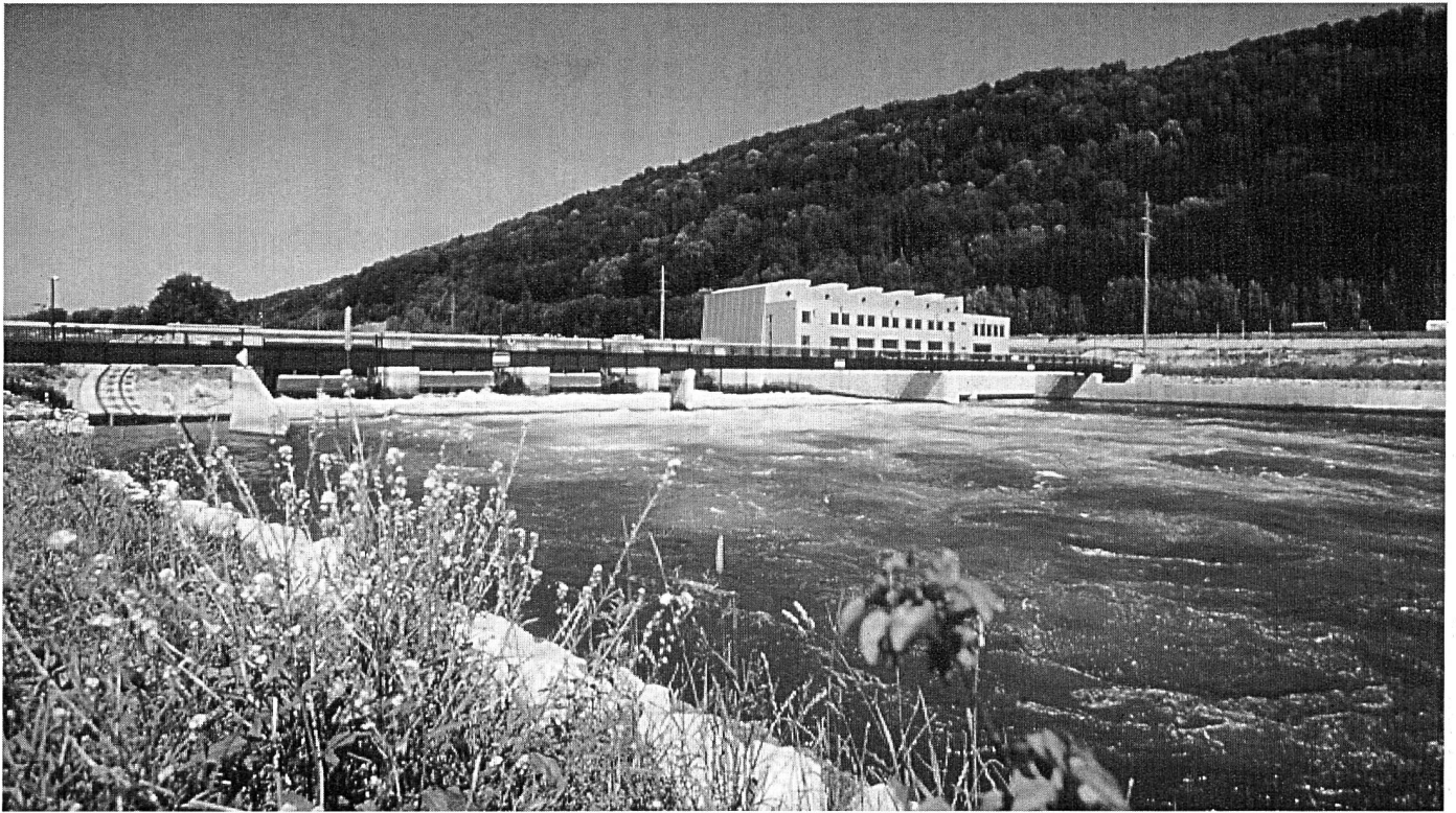
Das neue Kraftwerk Ruppoldingen ist ein Vorzeigebjekt – sowohl hinsichtlich modernster Technologie, als auch in Bezug auf die ökologischen Ausgleichsmassnahmen.
