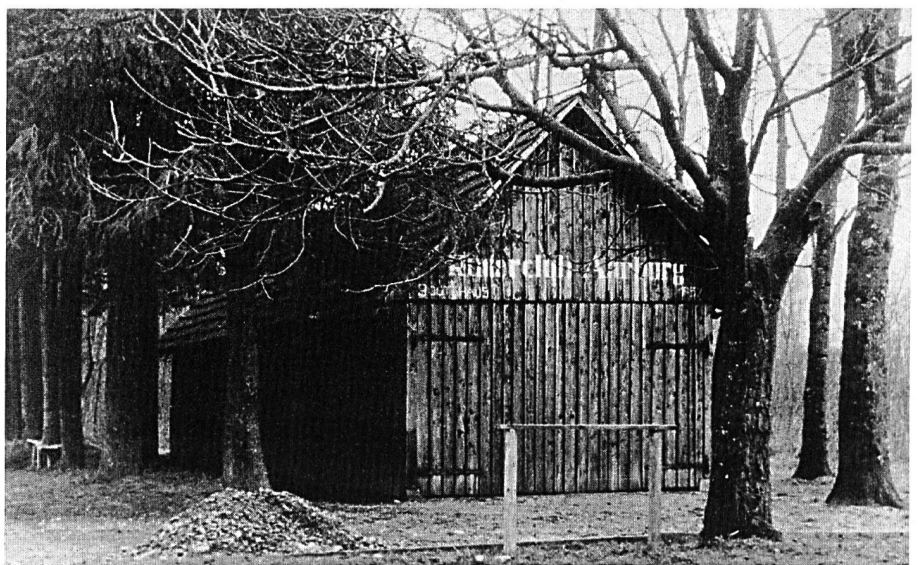
Das erste Aarburger Ruderhaus am Kraftwerkskanal Ruppoldingen. 4
