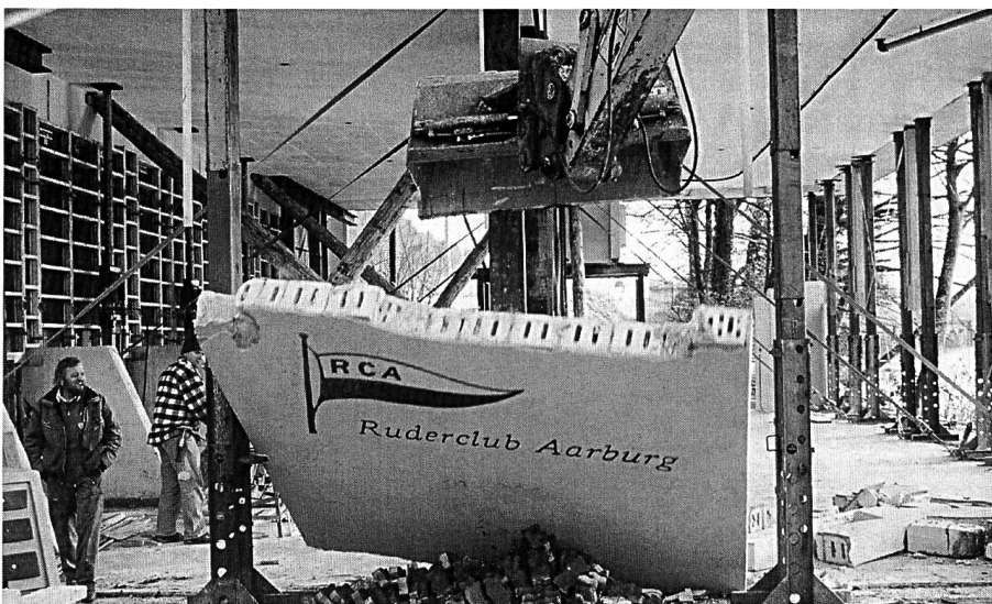
Die Hebung ist abgeschlossen. Jetzt fällt das letzte Teilstück der SW-Mauer mit Schriftzug und Fanion des RCA.
