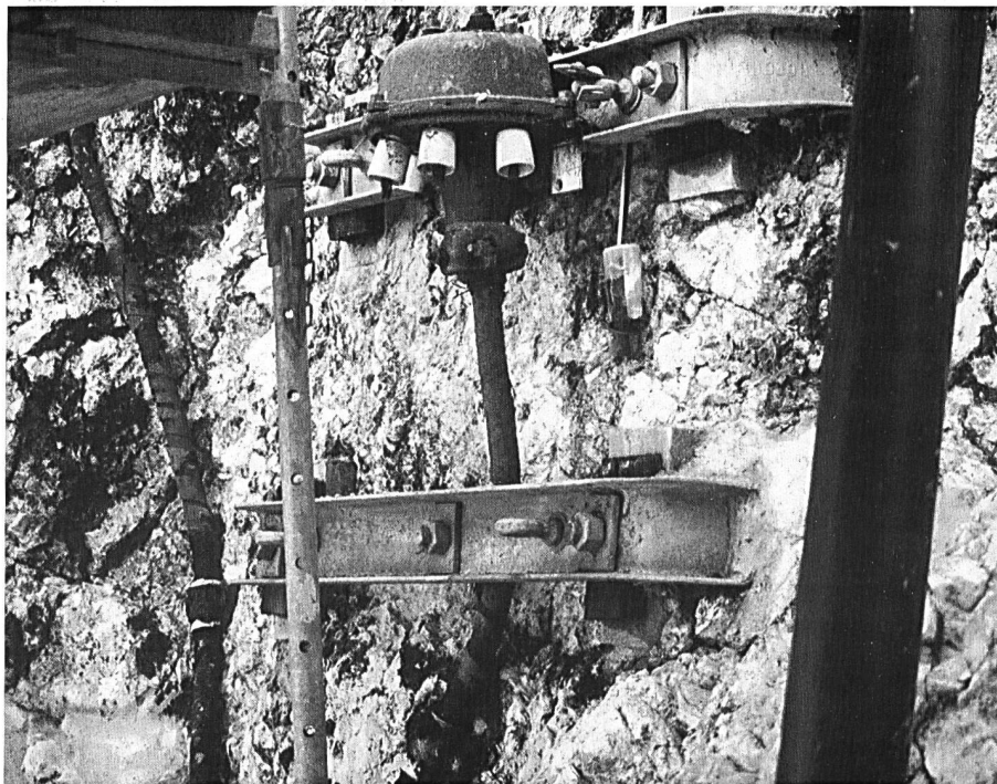
Veraltete Installationen, die entfernt oder ersetzt wurden.
