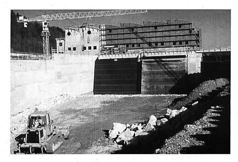
Grossmaul: Pro Sekunde fliessen maximal 450000 Liter Wasser durch den Rechen auf die beiden Maschinen.
