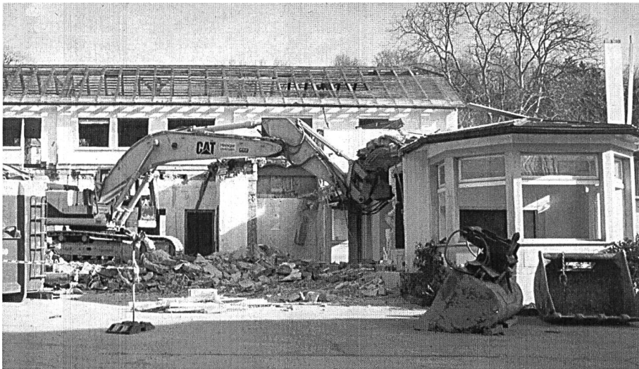
Das alte Pfarreizentrum wird abgebrochen.
