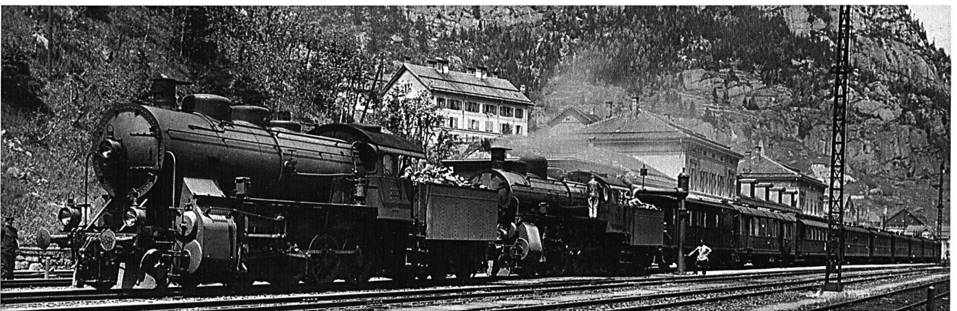
Um 1910, ein Jahr nach der Verstaatlichung der Gotthardbahn, erreicht die Dampftraktion auf der Gotthardlinie ihren absoluten Höhepunkt. Eine A 3/5 Schnellzuglokomotive führt den schweren Express, eine C 4/5 Güterzuglokomotive leistet ab Erstfeld Vorspann; beide noch von der Gotthardbahn beschafften Lokomotiven waren damals die modernsten und stärksten Maschinen auf der Bergstrecke. Der Betriebshalt in Göschenen betrug in jenen Jahren noch gut 25 Minuten, wovon das Bahnhof-Buffet Göschenen mit seinem berühmt gewordenen Perron-Service (heisse Suppe, Brot und Würstchen) jahrzehntelang profitierte.
