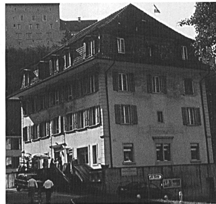
Die neuengerichtete Brockenstube im ehemaligen «Institut».
