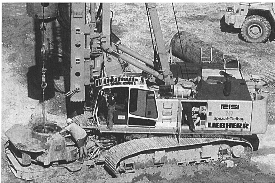
Stelzen für das Maschinenhaus. Rund 350 Pfähle mit je 120 Zentimetern Durchmesser wurden für das Fundament gebohrt.
