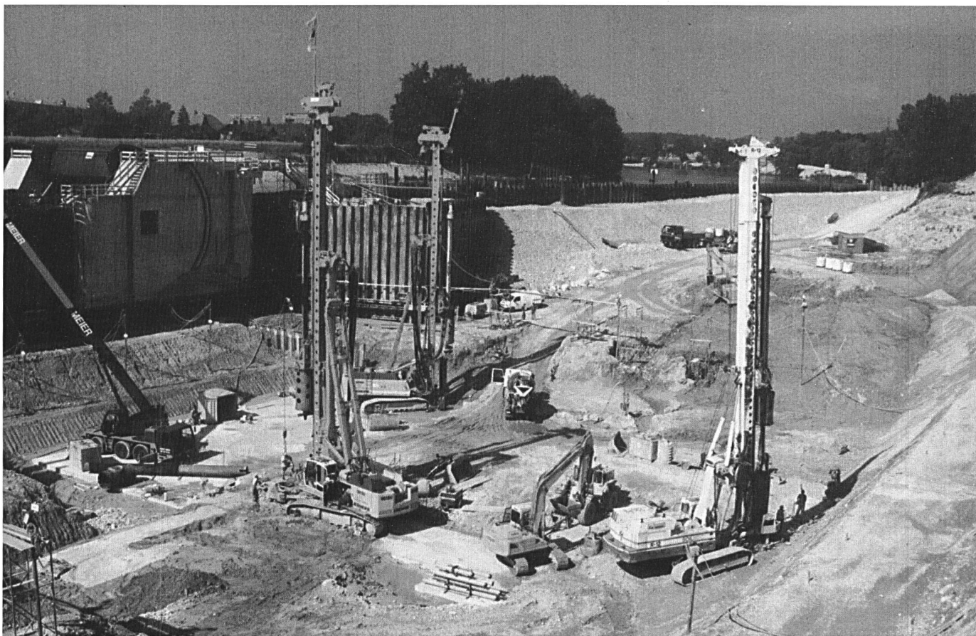
Ab in die Tiefe: Die Baugrube für das Maschinenhaus ist über 20 Meter tief.
