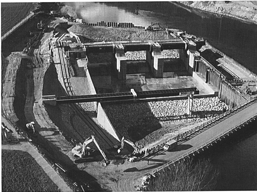
Noch liegt das fertig erstellte Stauwehr im Trockenem. Mitte Januar 1998 wurden die drei Wehröffnungen geflutet.
