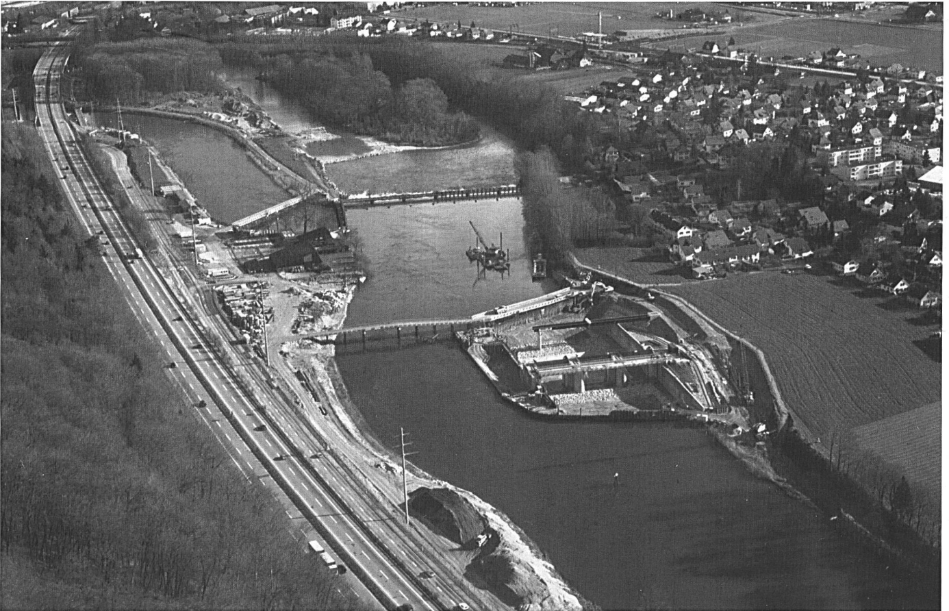
In der ersten Bauphase entstand das Stauwehr. 1998 begann der Bau des Maschinenhauses auf der linken Aareseite.
