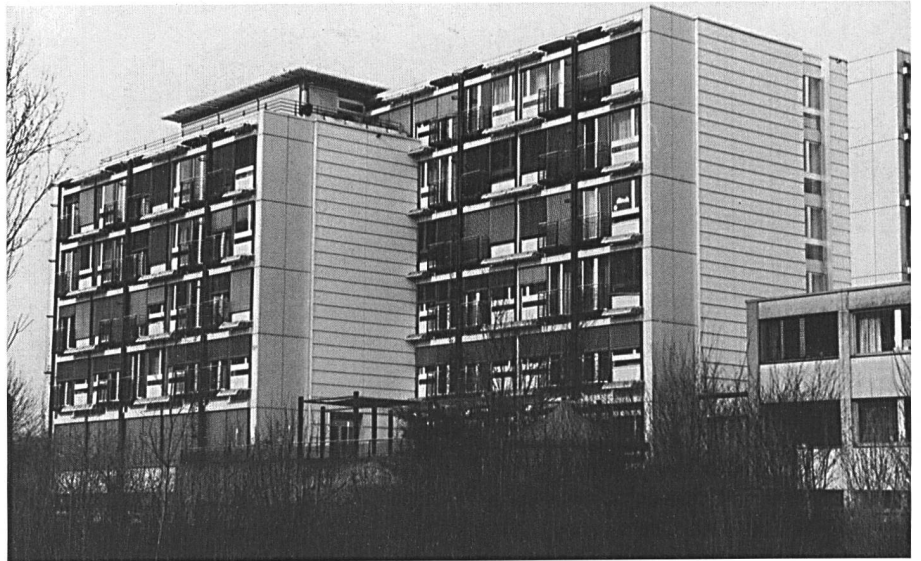
Die West- und ein Teil der Südfassade: Sie bewährt sich auch bei extremen Wetterverhältnissen — äussere Qualität im Alters- und Pflegeheim.
