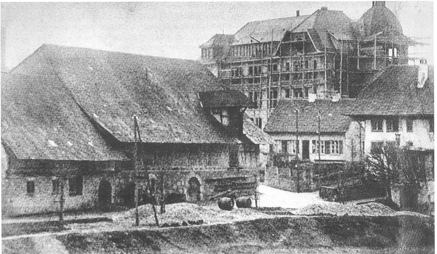
Das Schulhaus Hofmatt während den Bauarbeiten.
