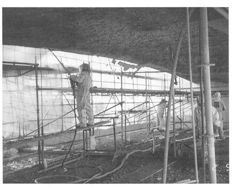
Nacharbeiten an den Rändern mit Lanze (Hochdruckwasserstrahl).
