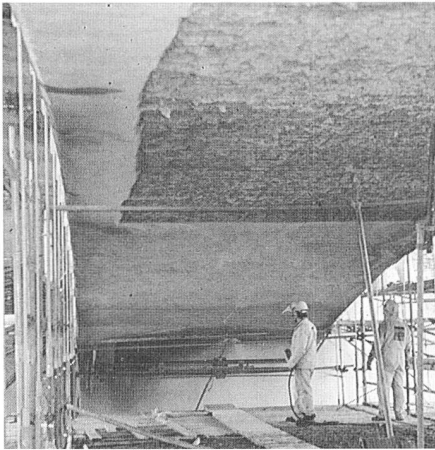
Mörtelabtrag an der Bogenuntersicht mit Hochdruckwasserstrahl-Roboter.
