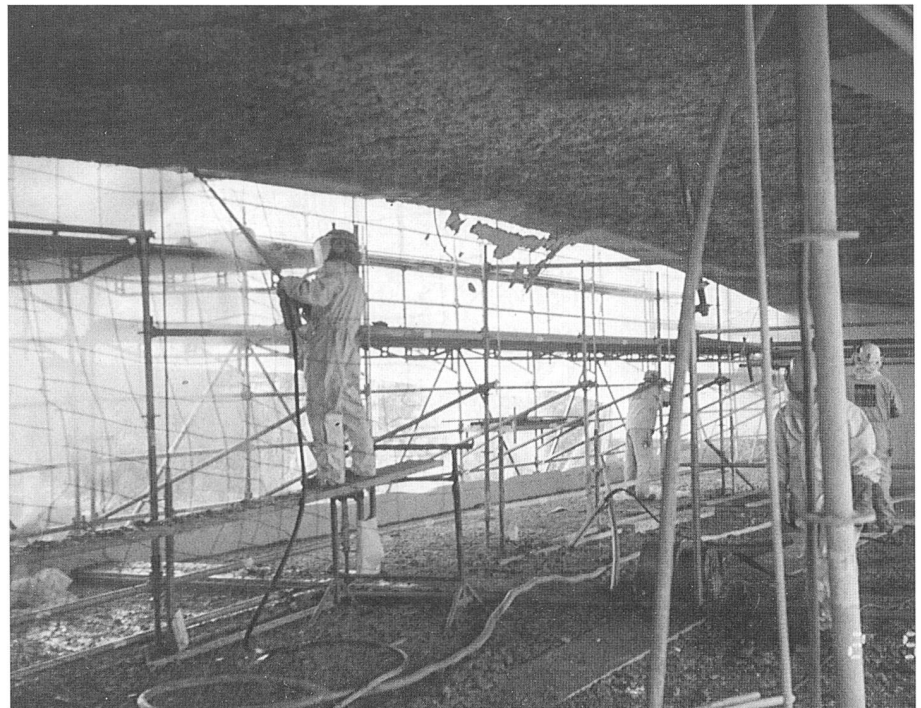
Nacharbeiten an den Rändern mit Lanze (Hochdruckwasserstrahl).
