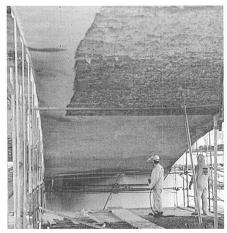
Mörtelabtrag an der Bogenuntersicht mit Hochdruckwasserstrahl-Roboter.
