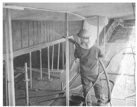
Spritzmörtelauftrag an den Längsträgern (Nass-Stromspritzverfahren).
