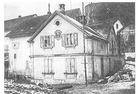
Der ehemalige Polizeiposten auf dem Centralplatz, abgebrochen 1916/17. Heute Arztpraxis Dr. Haller.
