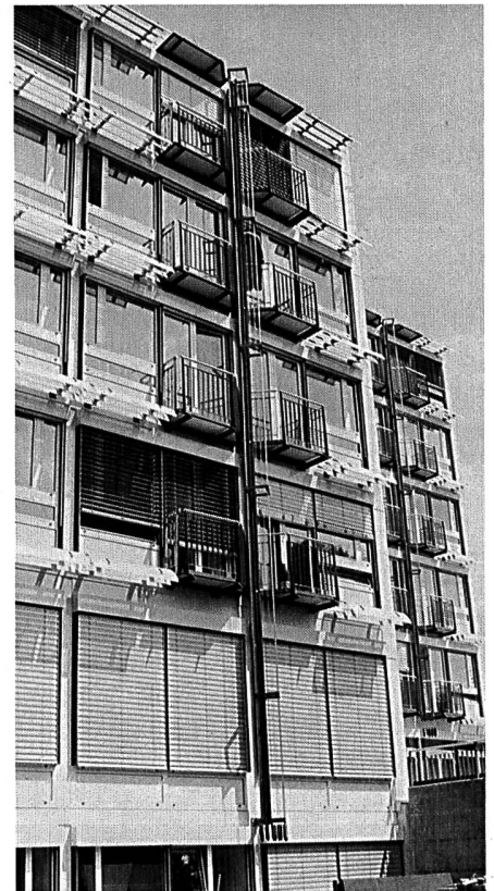
Die um 2,5 Meter vorverlegte neue Westfassade mit den kleinen Balkönl.
