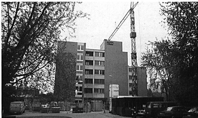
Im Altersheim Falkenhof begann die Sanierung.
