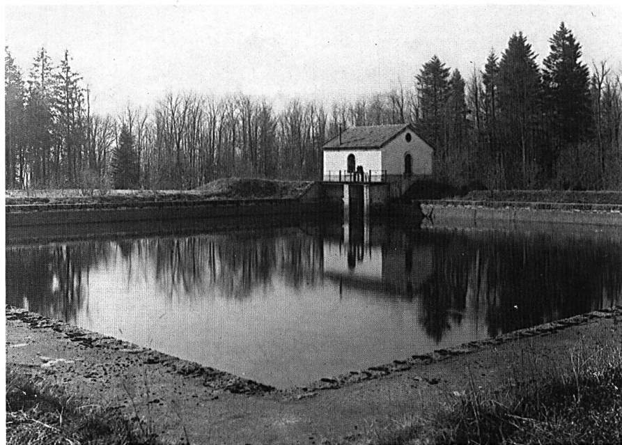
Speicherbecken mit Schieberhäuschen auf dem Born, 1904 realisiert, 1960 stillgelegt.
