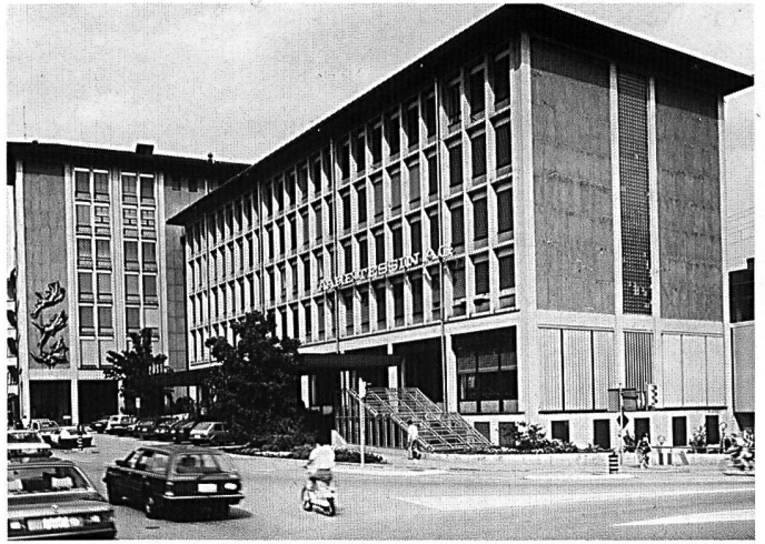
Das heutige Verwaltungsgebäude in Olten.
