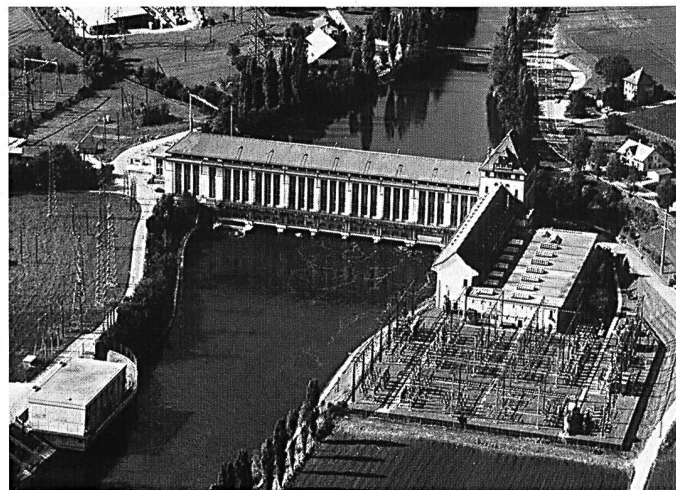
Das Maschinenhaus des Kraftwerkes Gösgen, 1915 bis 1917 erbaut, überspannt den 100 Meter breiten Kanal. Das Gefälle zwischen Oberwasser und Unterwasser (Bild) beträgt zwischen 14,5 und 17 Meter.
