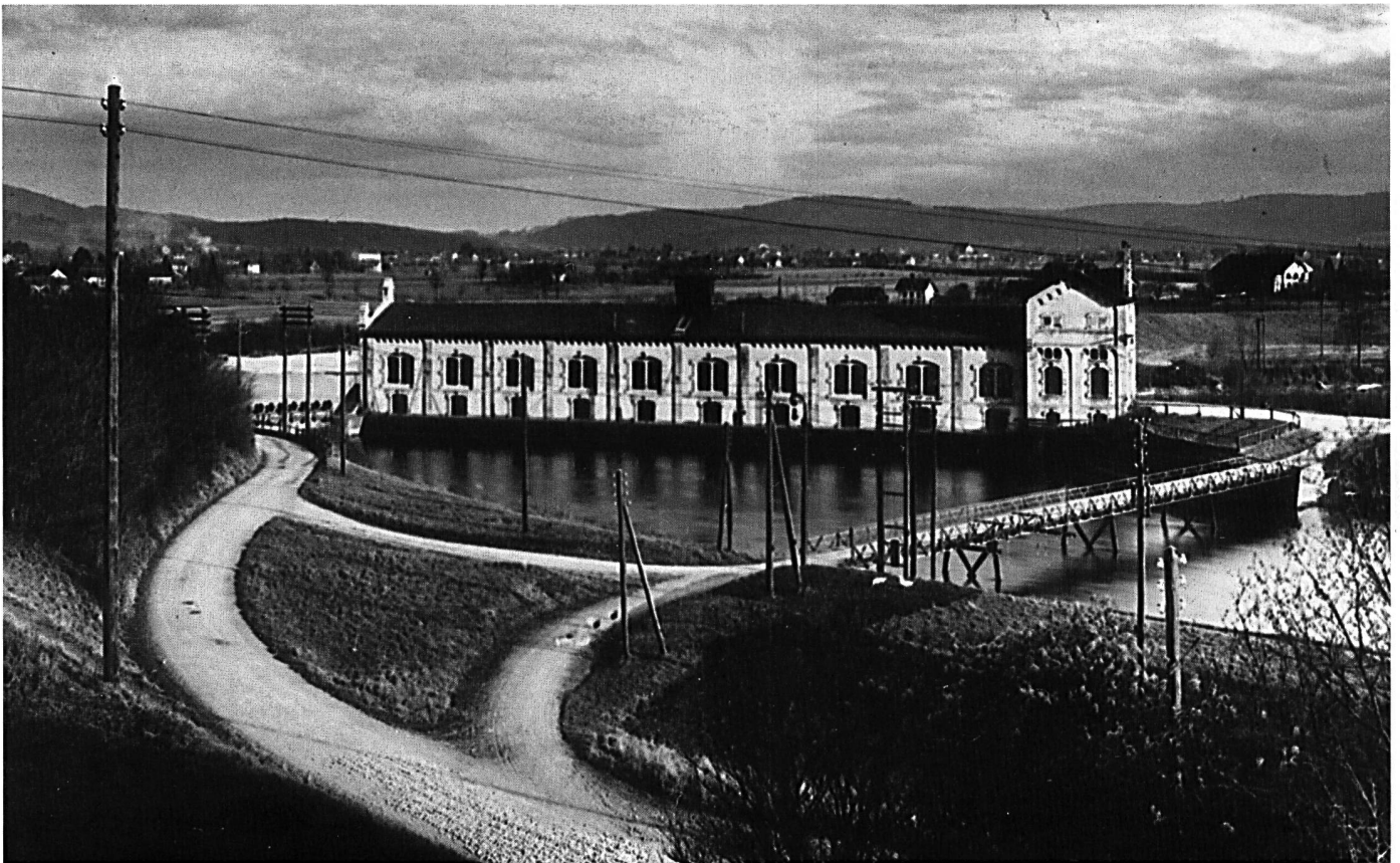
1896: Inbetriebnahme des Kraftwerkes Ruppoldingen.
