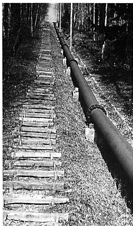
Druckleitung und «Tuusigerstägli». Abbruch Druckleitung 1960.
