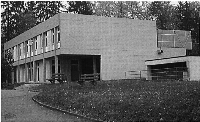
So präsentiert sich das Schützenhaus heute. Hinten sichtbar die nachträglich montierten Schallschluckwände.
