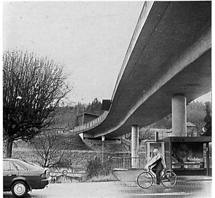
Die Überführung, welche die Wohnquartiere erschliesst.
