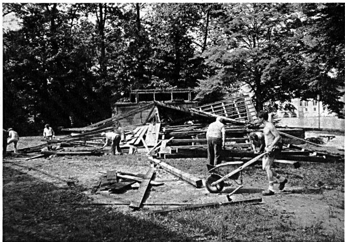
Abbruch des alten Bootshauses
