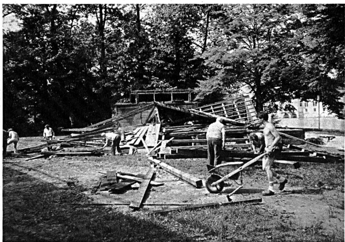
Abbruch des alten Bootshauses
