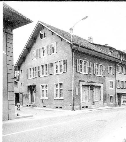
**BESCHREIBUNG** 3-geschossiger, verputzter Eckbau über Rechteckgrundriss (ca 8,5 m x 11 m) unter Satteldach, traufständig zur Bahnhofstrasse.
