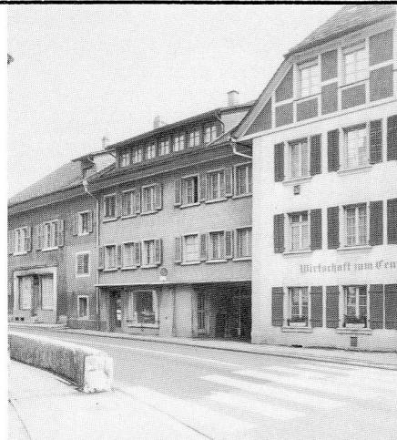
**BESCHREIBUNG** 3-geschoessiger, verputzter Massivbau über Rechteckgrundriss (ca 14, 8 m x 10 m) unter Satteldach mit breiter Schleppgaube, traufständig zur Bahnhofstrasse. Das Gebäude steht gleichfluchtend und hat die gleichen Trauf- und Firstlinien wie Nr. 274 (links). Es liegt gegenüber Haus Nr. 271 (rechts) um ca 1,2 m zurückgezogen.
