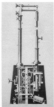
Bild 2 Kohlenbogenlampe nach Serrin aus dem Jahr 1879. Der Nachschub der beim Gebrauch sich verkürzenden Kohlen geschah durch einen uhrwerkartigen Mechanismus, kombiniert mit dem Schwerkraftprinzip und einer Elektromagnetbremse.
