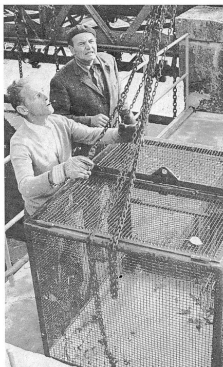
Die Reuse — unten links der Eingang — ist gesäubert und entleert. Mit einem Kettenhandzug wird sie wieder in den Fischpass hinuntergelassen.
