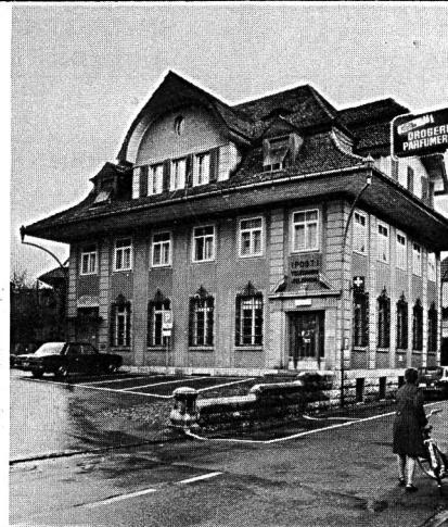
**BESCHREIBUNG** 2-geschossiger, verputzter Massivbau über Rechteckgrundriss (ca 12 m x 15,3 m) und unter Mansardwalmdach mit Quergiebel und Spitzgauben.
