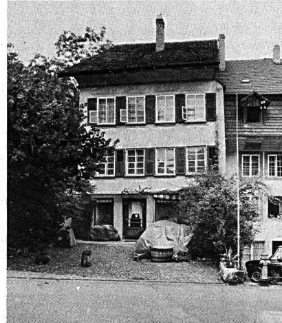
**BESCHREIBUNG** 3-geschossiger, verputzter Massivbau über grossem, trapezförmigem Grundriss (ca 7,3 - 6 m x 18,5 m) unter Satteldach, traufständig zur Torgasse.
