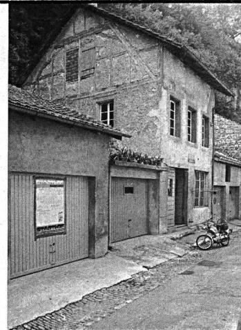
**BESCHREIBUNG** 2-geschossige, verputzte Mischkonstruktion (Bruchsteinmauerwerk und Fachwerkbau), traufständig zur Gasse unter Satteldach mit Quergiebel gegen den Felsen.
