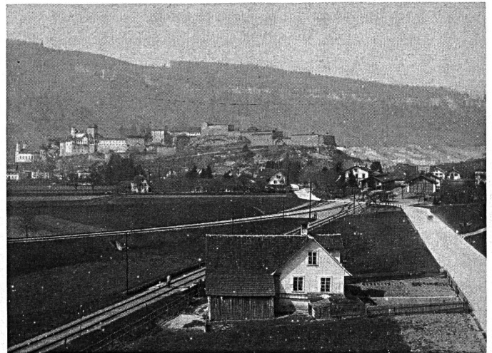
Blick von Süden auf den Bahnhof Aarburg (1885).
