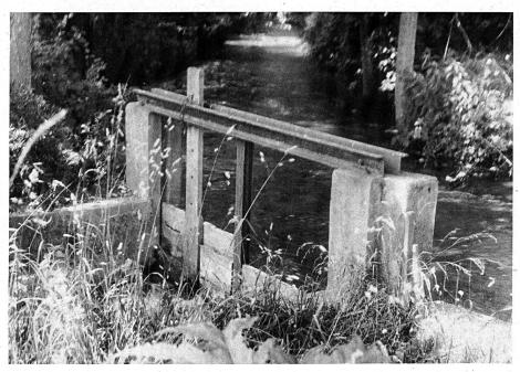
Die Wasserführung der Bewässerungsgräben — hier des Stampfibaches — wird mit Hilfe von «Brütschen» reguliert. Auf dem Bild Abzweigung vom Tych (rechts im Bild) beim Perrymarkt.
