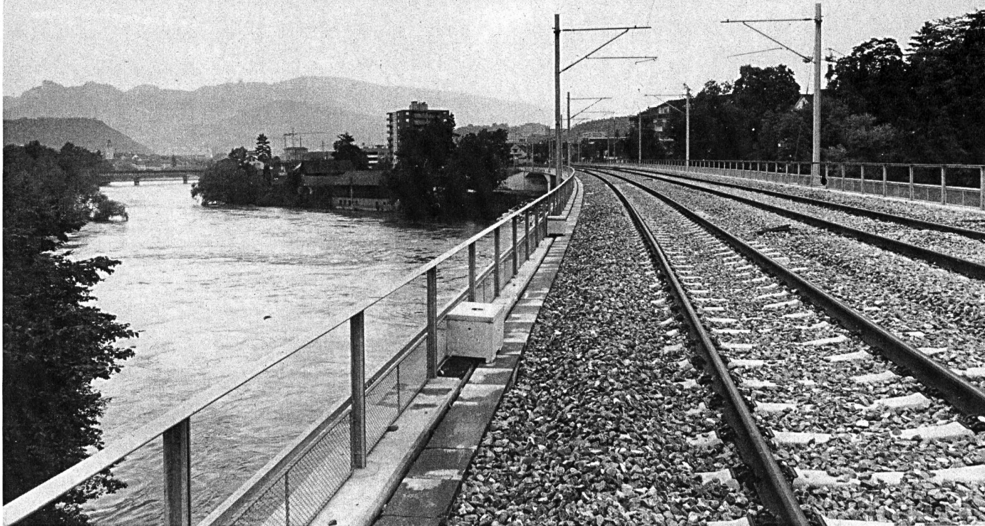
Brücke in der Kloos.
