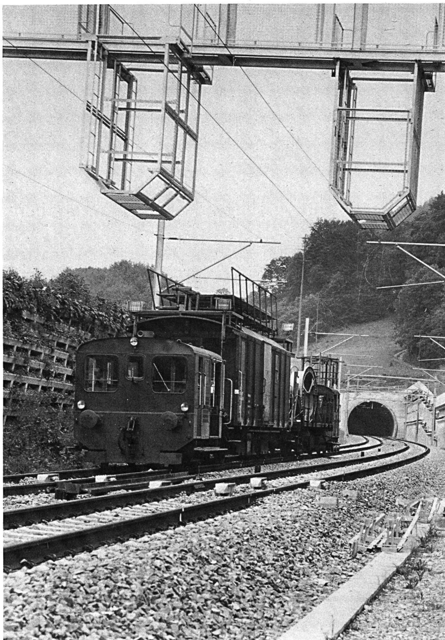
Nord-Portal Montage der Fahrleitungen. Links Lärm-Damm.
