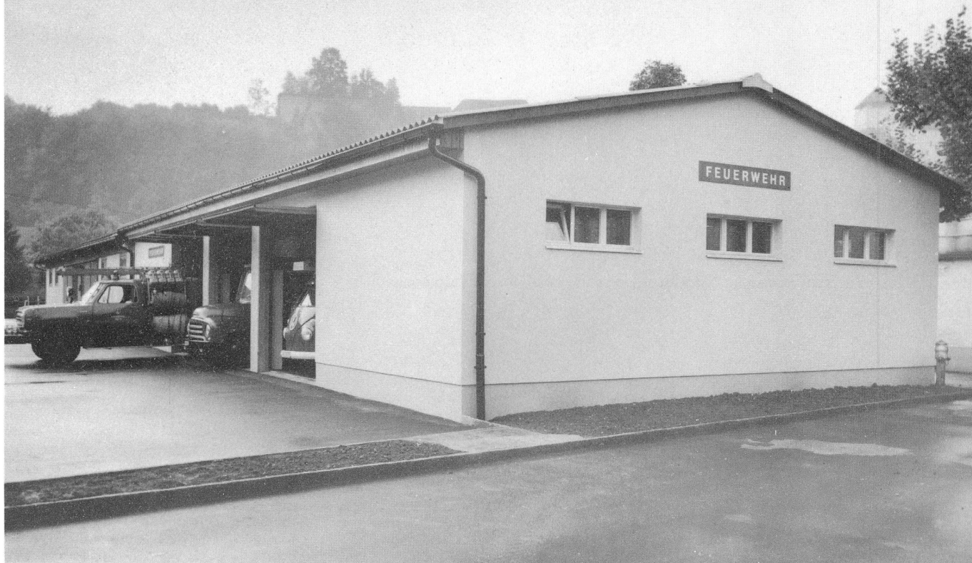
Das 1965 als Provisorium erstellte Feuerwehrdepot wurde 1968 ausgebaut und 1976 erweitert.
