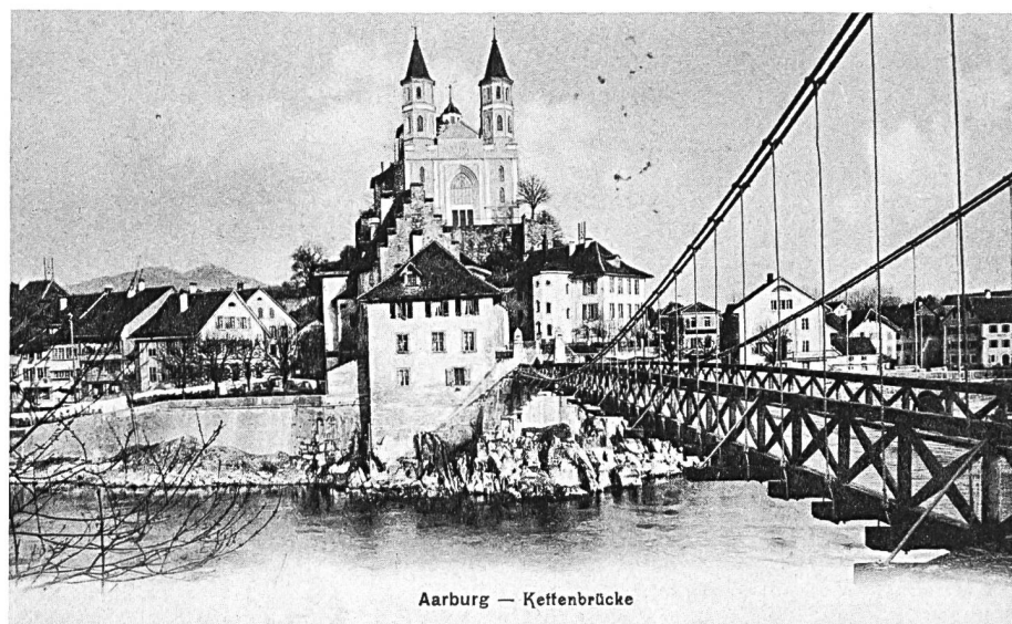
Volle 72 Jahre diente die idyllische Kettenbrücke dem Verkehr über die Aare, bis sie dem stets wachsenden Verkehr nicht mehr genügte und im Jahre 1911 abgebrochen und durch eine neue Betonbrücke ersetzt wurde. Phot. J. Rudolf, Aarburg
