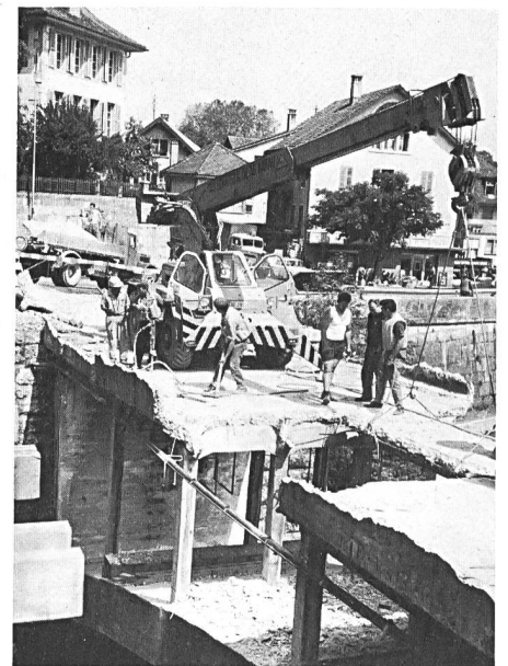
Links: 23. Juli: Der alte Oberbau der Brücke ist abgebrochen. Beginn der Betonarbeiten zur Verstärkung des Brückenbogens. Fotos: Gmünder
