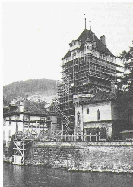
Schloss Oberhofen am Thunersee: Renovation (Bild: Comet)
