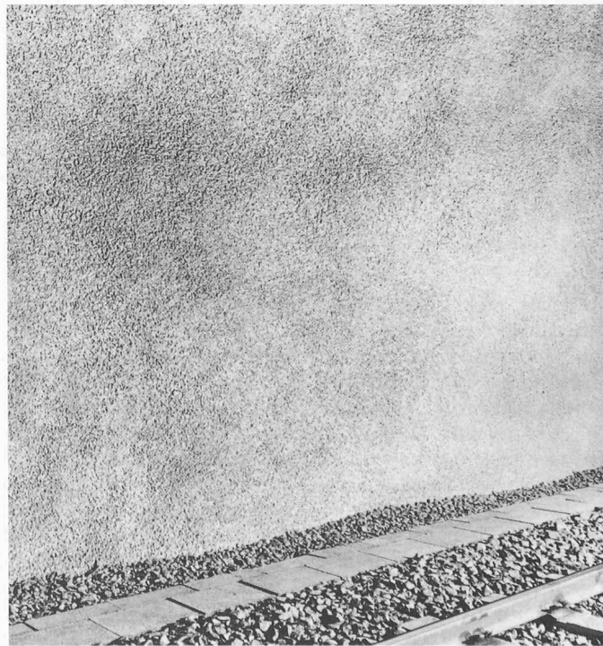
Bild 11. Sorgfältig hergestellte Spritzbetonfläche (Foto: O. Pfeifer, Luzern)
