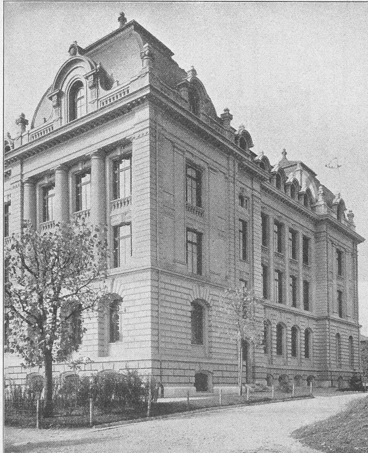
Abb. 12. Ansicht der östlichen Seitenfassade des Gebäudes.
