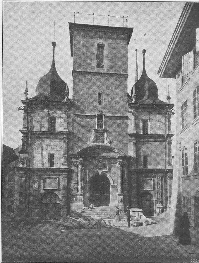
Abb. 1. Die alte Ostfassade des Rathauses zu Solothurn.
