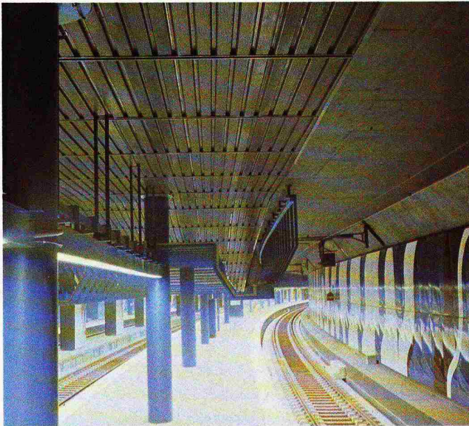
Bild 3. Perrongeschoss mit Vollstahlstützen
