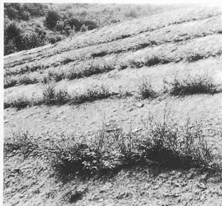
Bild 4. Salzweid N1. Drei Monate nach Einbringen der Buschlagen waren die Weiden bereits 60 cm hoch gewachsen. (Stabilbauweise)
