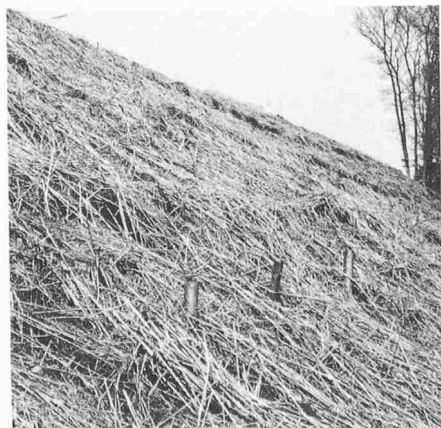
Bild 15. Kerzers N1, Mühle Grau. Die geschüttete Kiesböschung wurde mit Steckhölzern vernagelt, hinter welche Weidenstämme gerollt wurden; die Fläche wurde mit Schilf abgedeckt. (Stabilbauweise)
