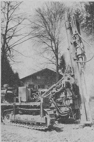
reich erstellt. Zum Errichten einer Grundwasserwanne im Felssturzgebiet musste man von 4600 m<sup>2</sup> unebenem Gelände etwa 1500 m<sup>2</sup> in Flächensprengung abbohren, teils unter Wasser. Ausserdem wurde das wegzuräumende Gestein durch Sprengen zerkleinert, um baggerfähiges Haufwerk zu erhalten. An diesen Arbeiten war der
